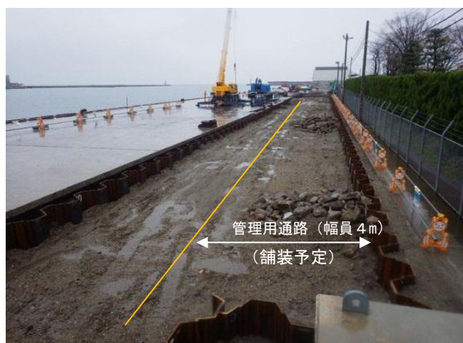
鋼矢板打設完了
